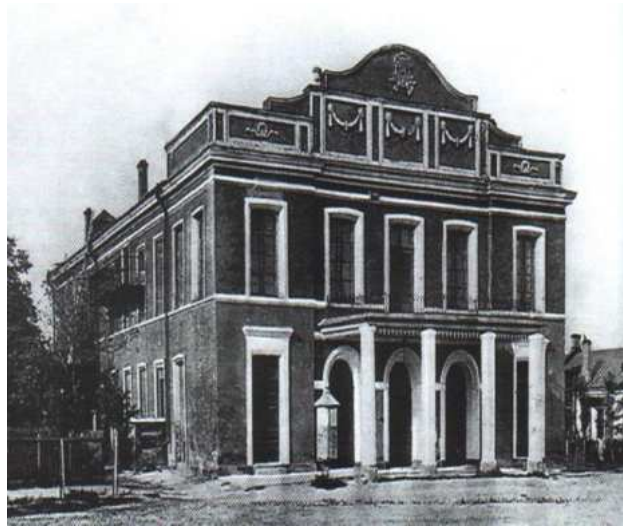
Будівля театру в м. Єлисаветград (м. Кропивницький)
