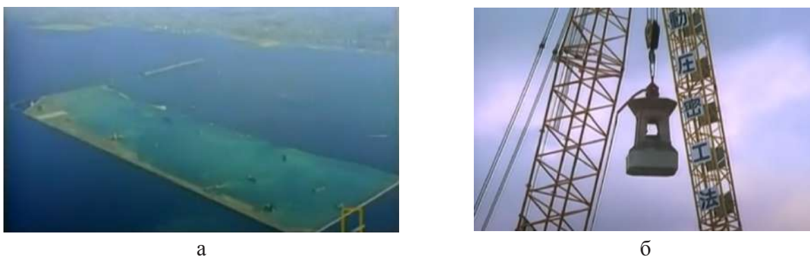
Рис. 3. Будівництво штучного острова: а – контури майбутнього острова [4]; б – трамбувальний блок [3]
