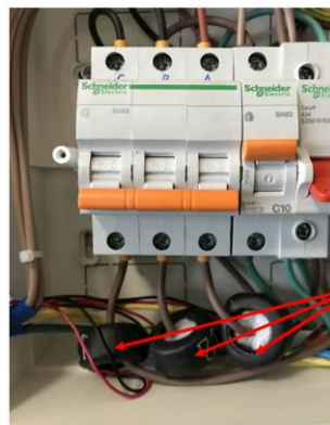
Рисунок 4 – Приклад інсталяції сегменту системи енергетичного моніторингу для навчальної аудиторії університету
