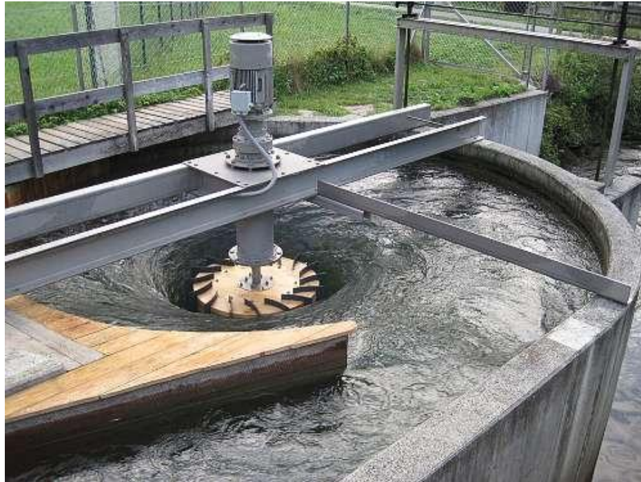
Рисунок 1.3 — Конструкція вирової ГЕС, встановленої на водяному потоці з низьким напором
