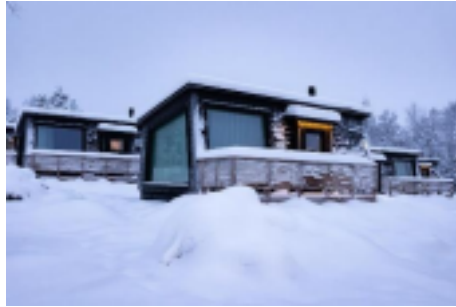
Мал.1.4 KM Villas – котеджне містечко у м.Київ , Бровари.
