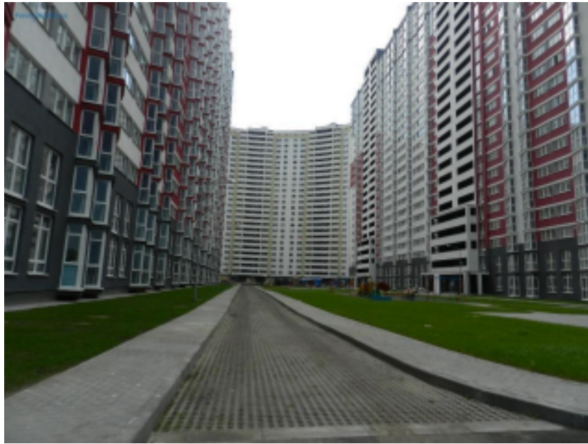
Рис. 1. Приклад надмірної щільності забудови, що призводить до дефіциту інсоляції та порушення візуального комфорту мешканців.
