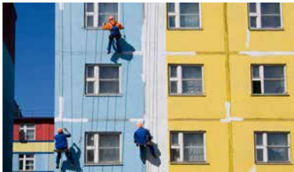
Рис.2 Ремонт і фарбування фасадів.
