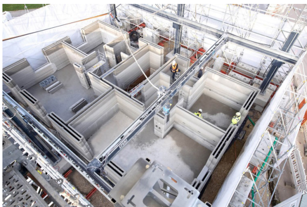
Рисунок 1 – Процес 3d-друку будівлі
