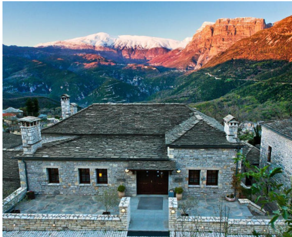
Рис. 2.5. Готель «Aristi Mountain Resort & Villas» (Греція)
