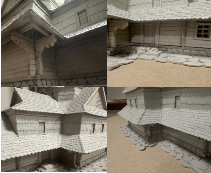
Рис. 3. Стіни першого і другого ярусів, випуски вінців зрубу та піддашся
