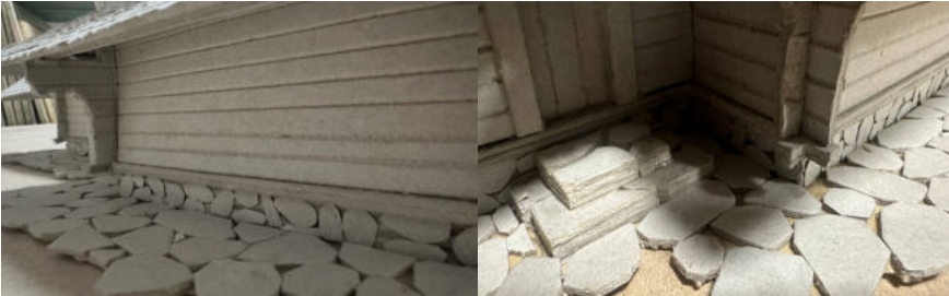
Рис. 2. Фрагмент мощення, фундамент й підваolini
